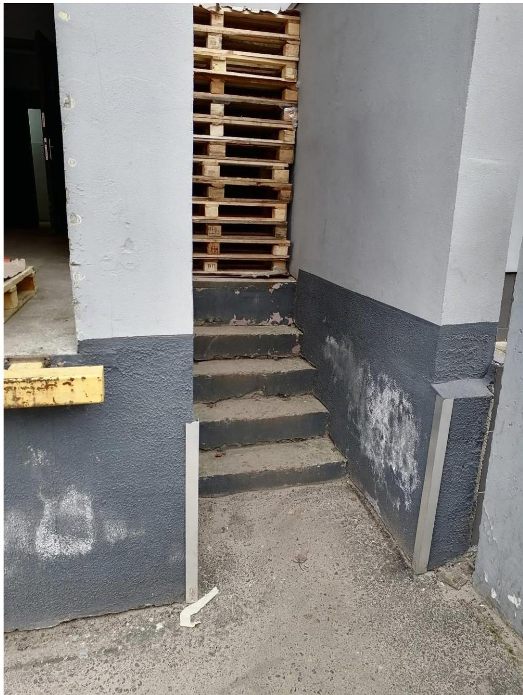
*Проход на погрузо-разгрузочную рампу заставлен поддонами*
