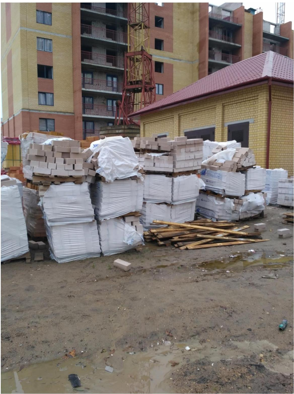
*Площадка для складирования без твердого покрытия, не обеспечена устойчивость складируемых материалов.*
