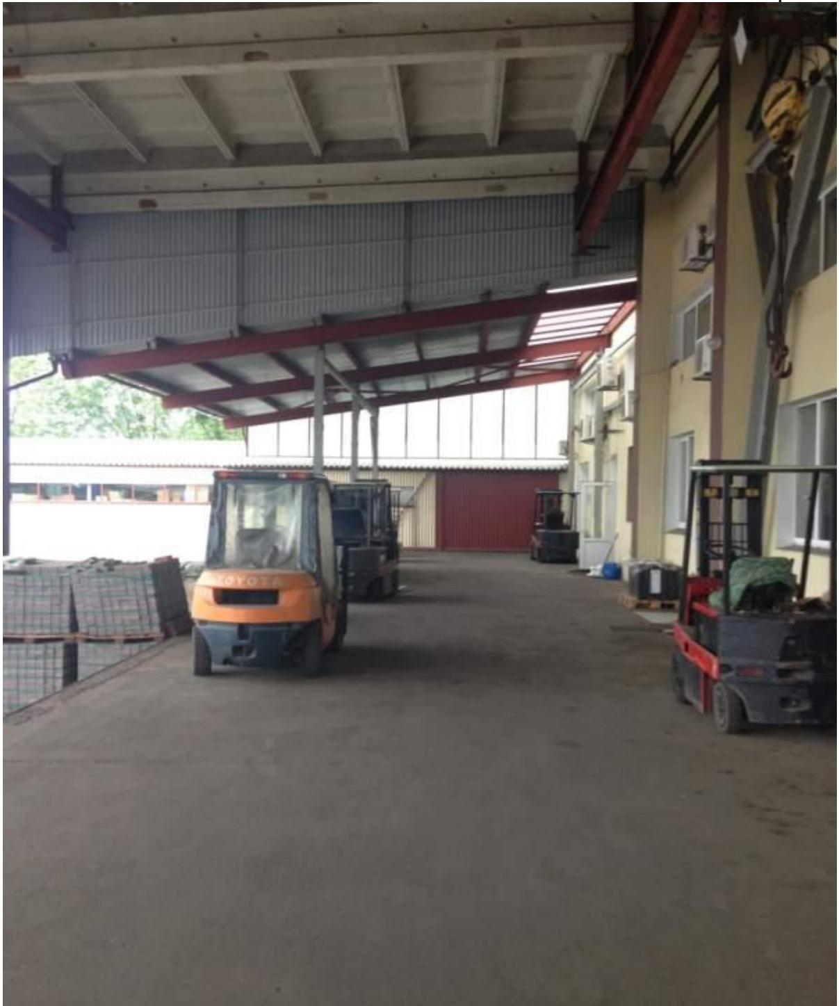
*Отсутствуют колесоотбойные предохранительные устройства, препятствующие съезду и опрокидыванию безрельсового напольного транспорта*
