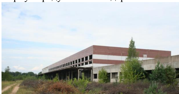
Здание холодильника с компрессорной
