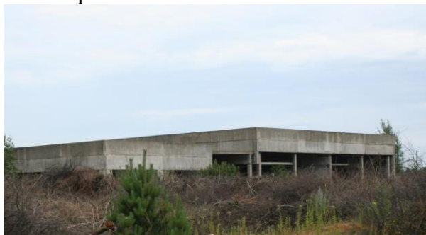
Блок подсобных цехов
