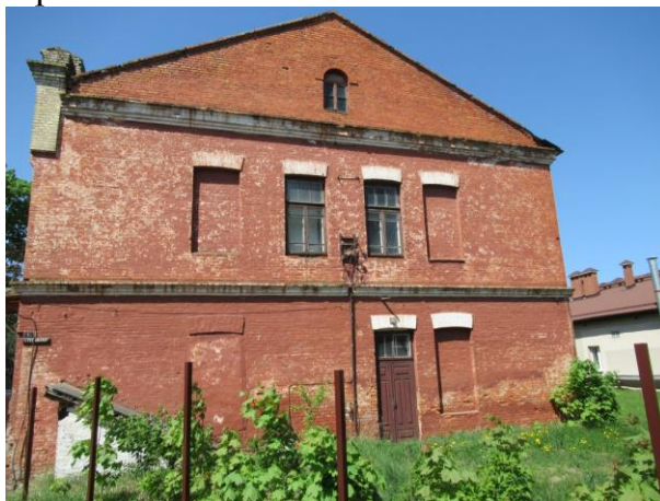
Боковой фасад дома пионеров со двора
